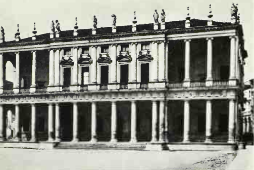
295. ANDREA PALLADIO. Façade, Palazzo Chiericati, Vicenza. Begun 1551. 58' × 138'
