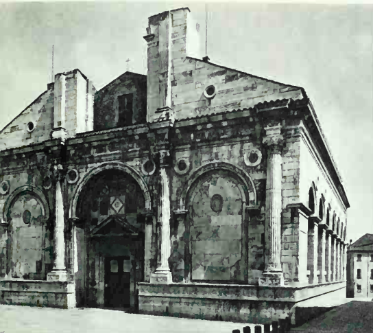
101. LEON BATTISTA ALBERTI. Exterior. S. Francesco, Rimini. Designed 1450. Width of façade 96'
