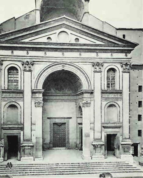
103. LEON BATTISTA ALBERTI. Façade, S. Andrea, Mantua. Designed 1470. Height to top of pediment 75'
