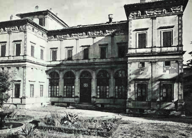
221. BALDASSARE PERUZZI. Garden façade, Villa Farnesina, Rome. 1509-11. 58' × 121'
